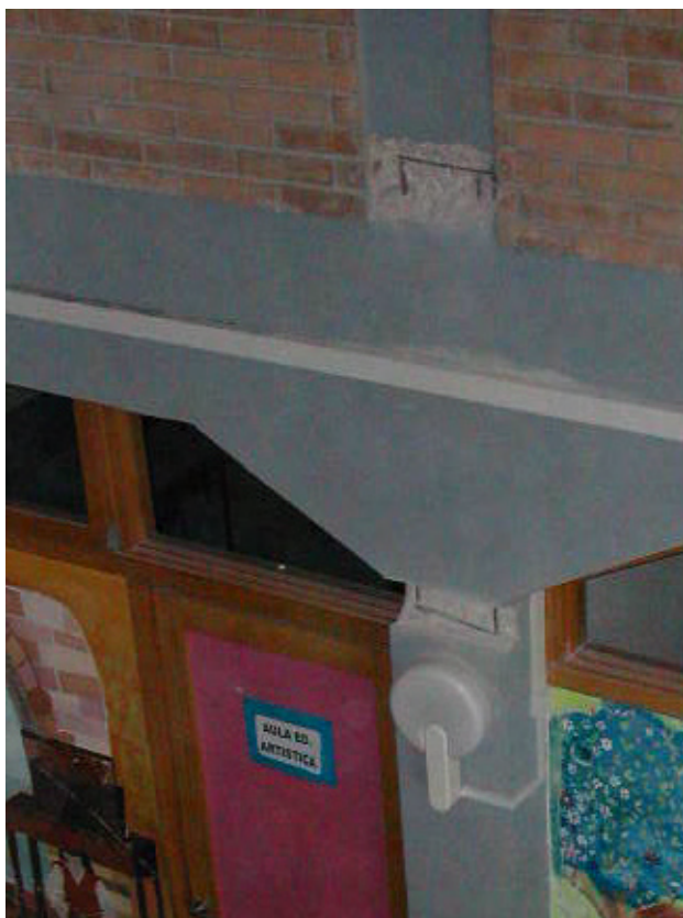
Figura 8. Sondaggi su edifici in c.a. per valutare armature
