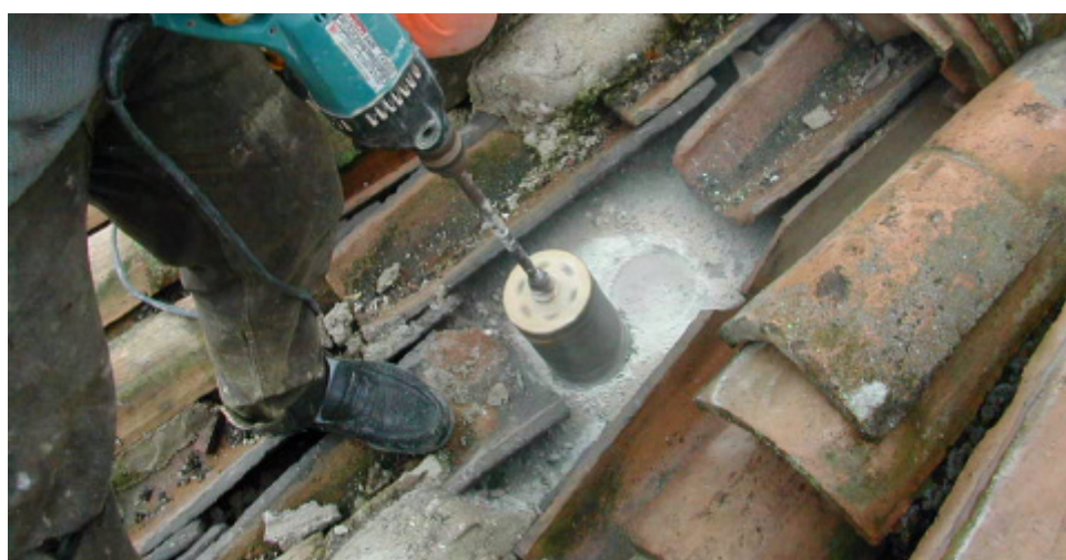
Figura 12. Indagini diagnostiche su strutture di copertura
