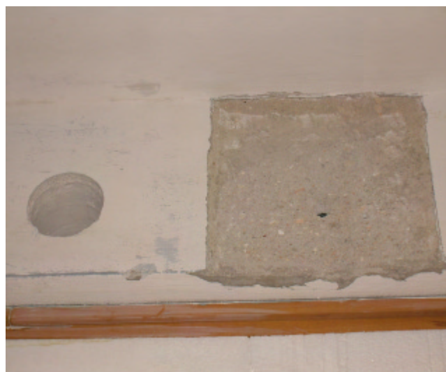
Figura 9. Prove distruttive (carotaggi) e non distruttive (sclerometriche) su edifici esistenti in c.a.
