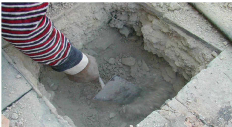
Figura 11. Sondaggi su strutture orizzontali
