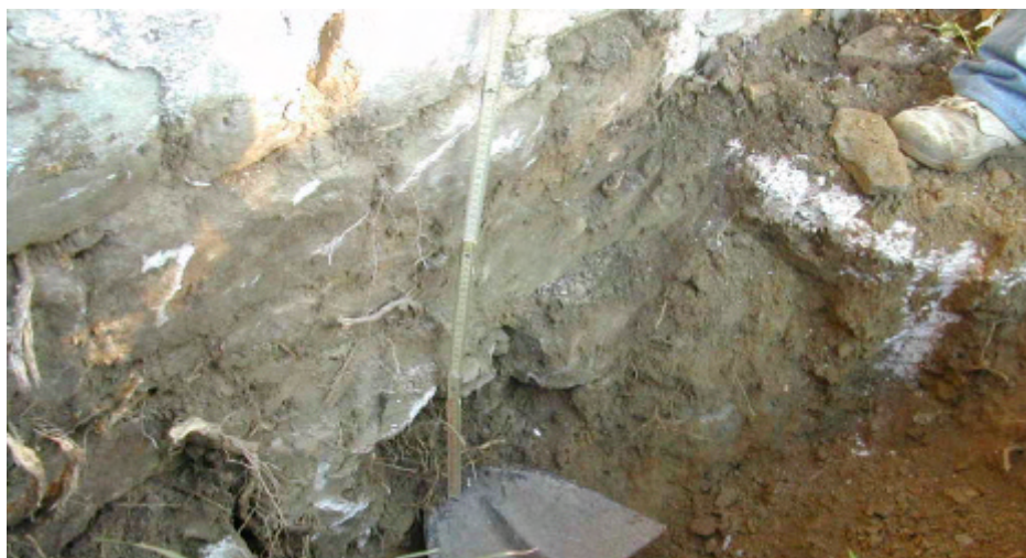
Figura 10. Sondaggi su fondazioni
