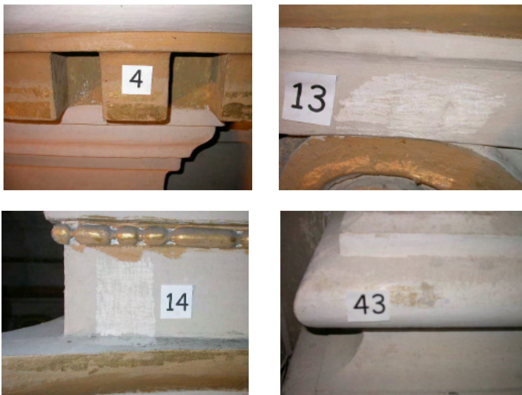
Figura 5. Sondaggi su affreschi pre-restauro
